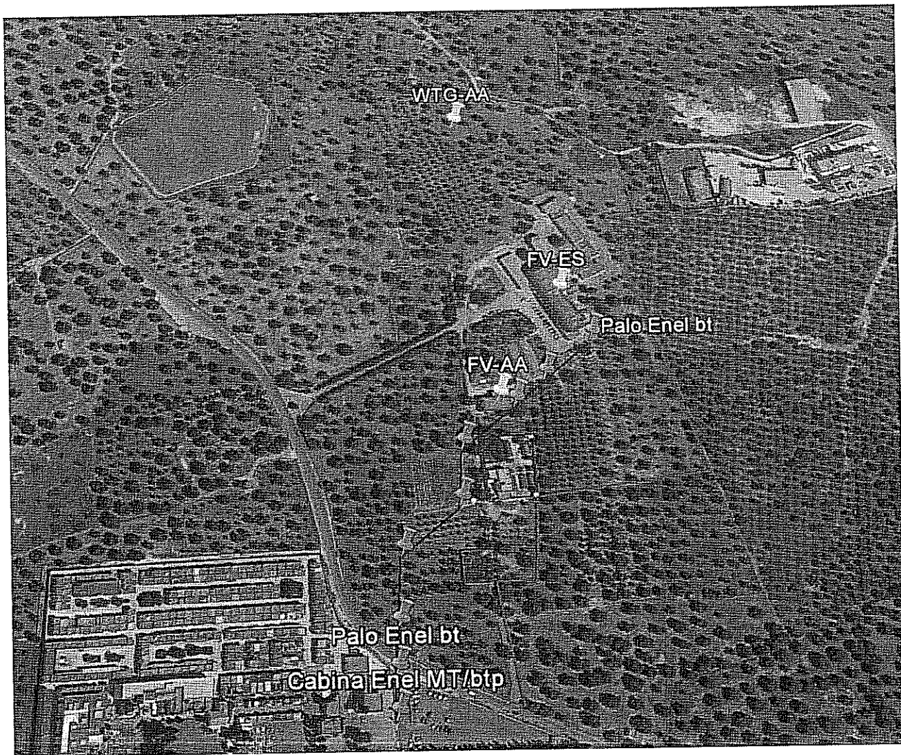
Figura 11 – Linea aerea di competenza Enel Distribuzione, che alimenta i contatori di utenza in bt
